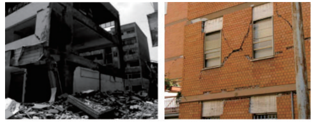
(a) 平面外地震作用下外墙倒塌 (b) 平面内-外耦合地震作用的震害 图27 普通填充墙平面外震害
